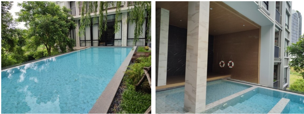
ภาพที่ 4-23 โครงสร้างสระว่ายน้ำ คอนกรีตเสริมเหล็ก ปูกระเบื้อง ไม่มีรอยแตกร้าว และมีห่วงยางสำหรับช่วยชีวิตไว้แล้ว
