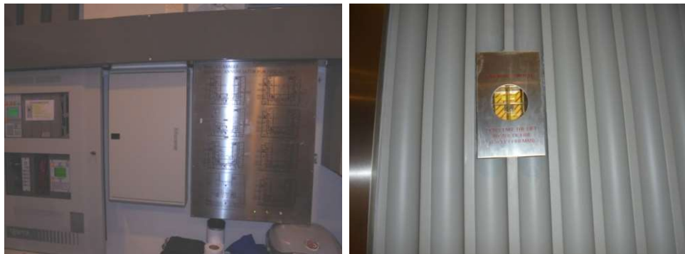
ภาพที่ 4-28 อุปกรณ์แจ้งเหตุอัคคีภัยและศูนย์รับแจ้งเหตุเพลิงไหม้
