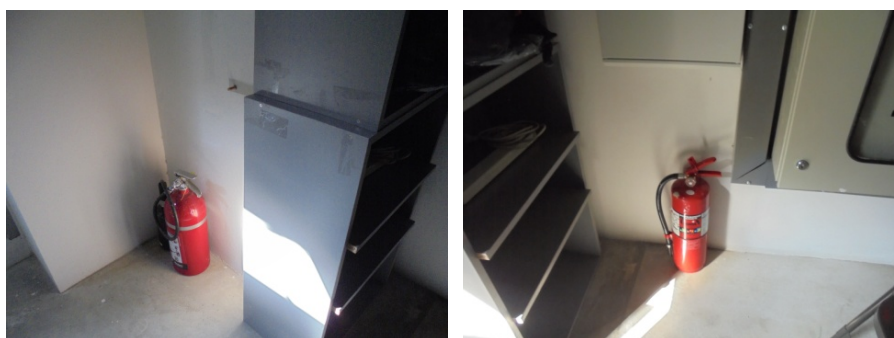
ภาพที่ 4-26 ถังเคมีดับเพลิงและป้ายแนะนำวิธีการใช้ติดอยู่กับอุปกรณ์
