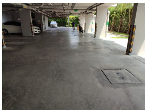
ภาพที่ 4-22 แนวรางระบายน้ำและท่อระบายน้ำและฝาท่อเป็นฝาคอนกรีต ไม่มีขยะอุดตัน
